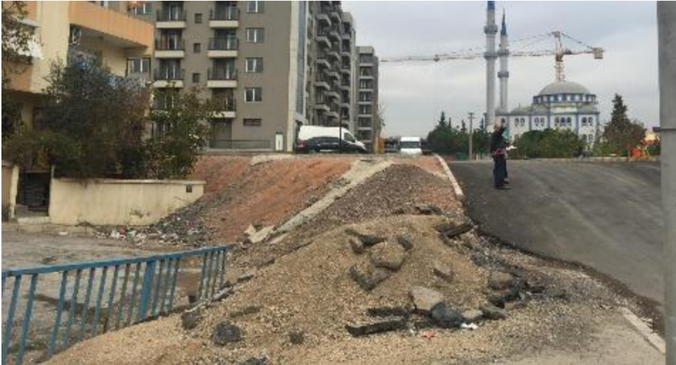
Şekil 3. Çalışma alanı mevcut durumu
