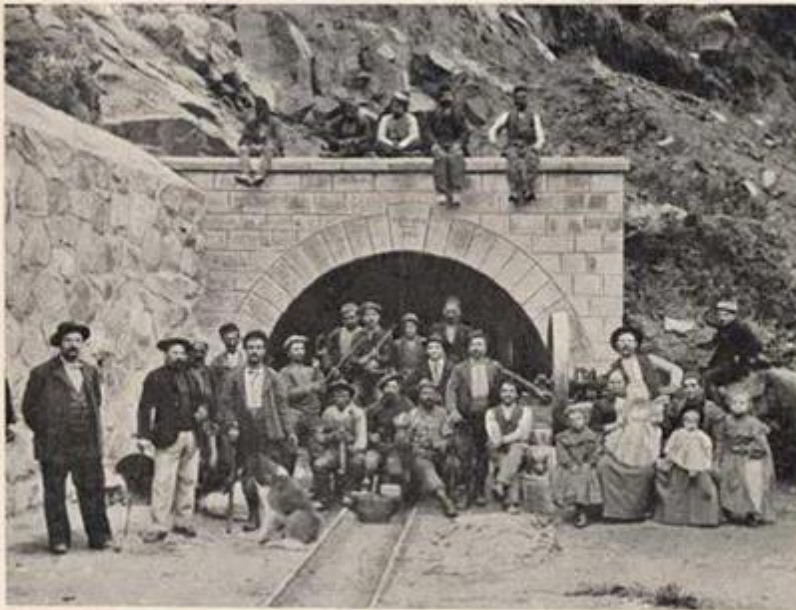
SOCIÉTÉ OTTOMANE D'HÉRACLÉE TUNNEL D'UZULMEZ
