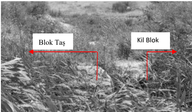
Şekil 4: Blok Taş ve Kil Unsurlardan Oluşan Su Tahliye Noktasına Bir Örnek (Orijinal 2019)
