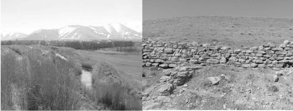
Şekil 1: Sol: Minua (Şamram) Kanalı'nın Yamaç Boyunca İnşası. Sağ: Dik Yamaçlara İnşa Edilen İstinat Duvarlarından Bir Örnek (Orijinal, 2019).
