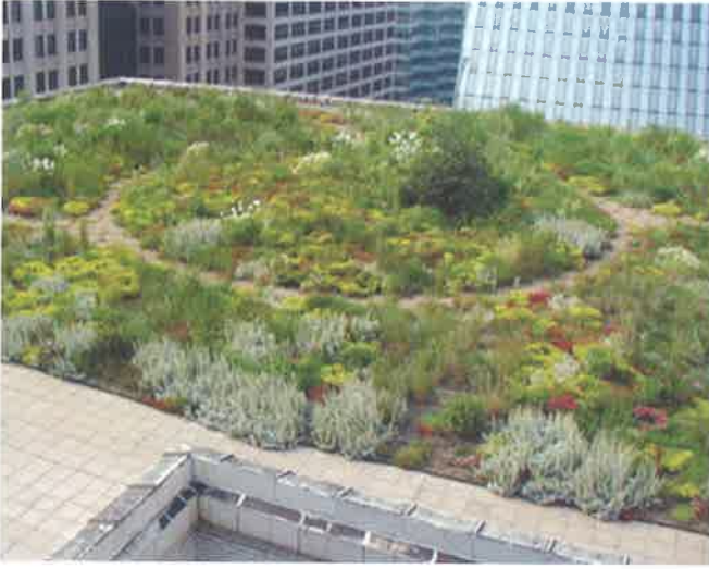
Şekil 8. Çatı bahçeleri düzenlemeleri ile yağmur suyu kaynağında kontrol edilmektedir.
