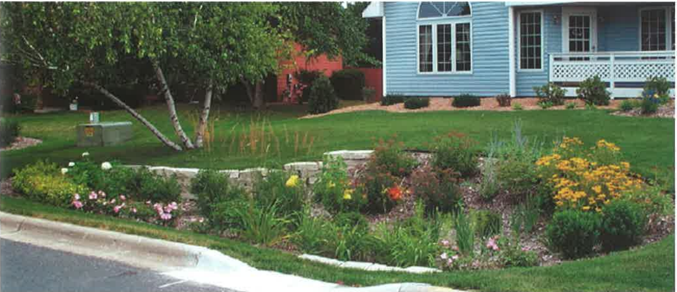
Şekil 7. Konut bahçelerinde küçük ölçekli toplama havzalarının oluşturulması ve bunların estetik amaçlı değerlendirilmesi ile bireysel ölçekte yararlar sağlanır. Bu örnekte, arazinin alçak bölgesinde yer alan çiçek parterleri yağmur suyu denetiminin bir parçası olan su toplama havzası olarak değerlendirilmiştir. Yol kenarında akan su, bordür düzenlemesi ile bu alana yönlendirilmektedir.
