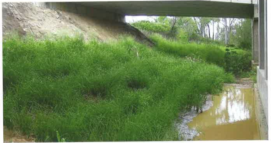
Şekil 3. Açık kanallarda Vetiver çimi gibi derin ve sık köklü bitkilerin kullanılmasıyla su akış hızı kontrol edilirken yüzey suyu içindeki materyaller filtre edilebilir.
