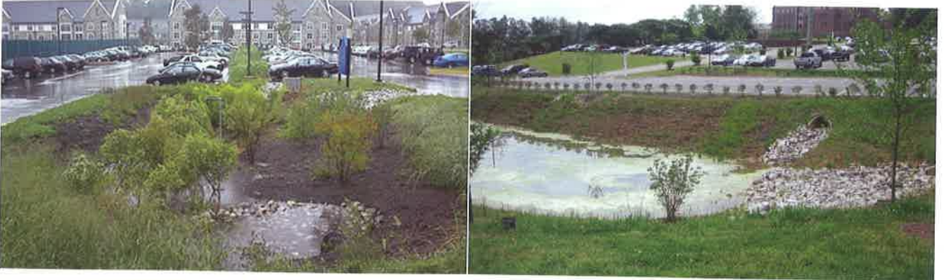
Şekil 13. Otoparkların çevresi de yağmur suyu denetimi için değerlendirilmelidir. Bu örneklerde, su toplama havzası olarak kullanılan bitkisel alanlar görülmektedir.
